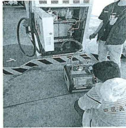
7.2 现场检测照片
