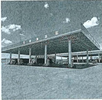
7.1 加油站全景照片
